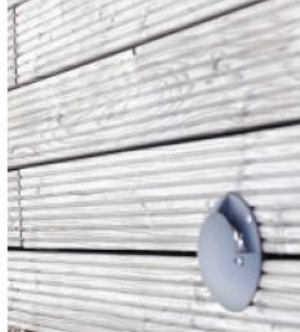
Verlichting in houtwerk, tussen 2 brugdek delen
