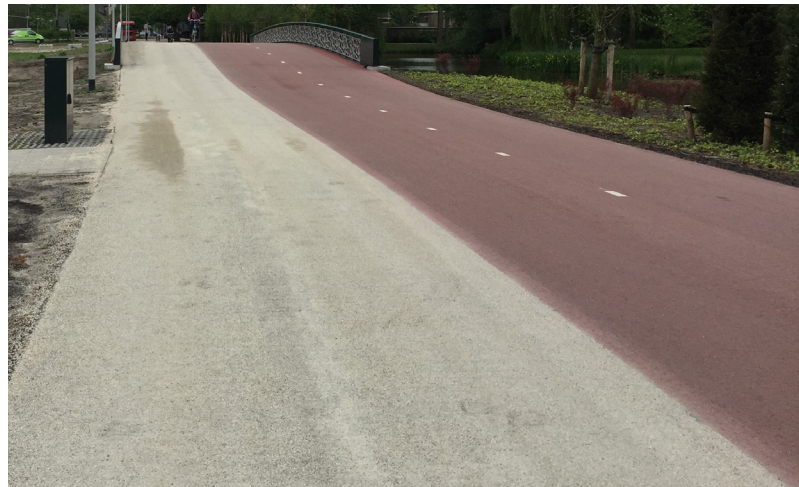
Pannakooi: asfalt met parelgrind afgestrooid (parelgrind zelfde kleur als stabilizer). Fietspad: rood asfalt, kleur n.t.b.
