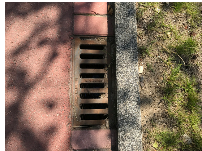
Fietspad en Voetpad: Straatkolk ODS* 450x200 mm, gietijzer, in rollaag van Terra rossa (KF)*
