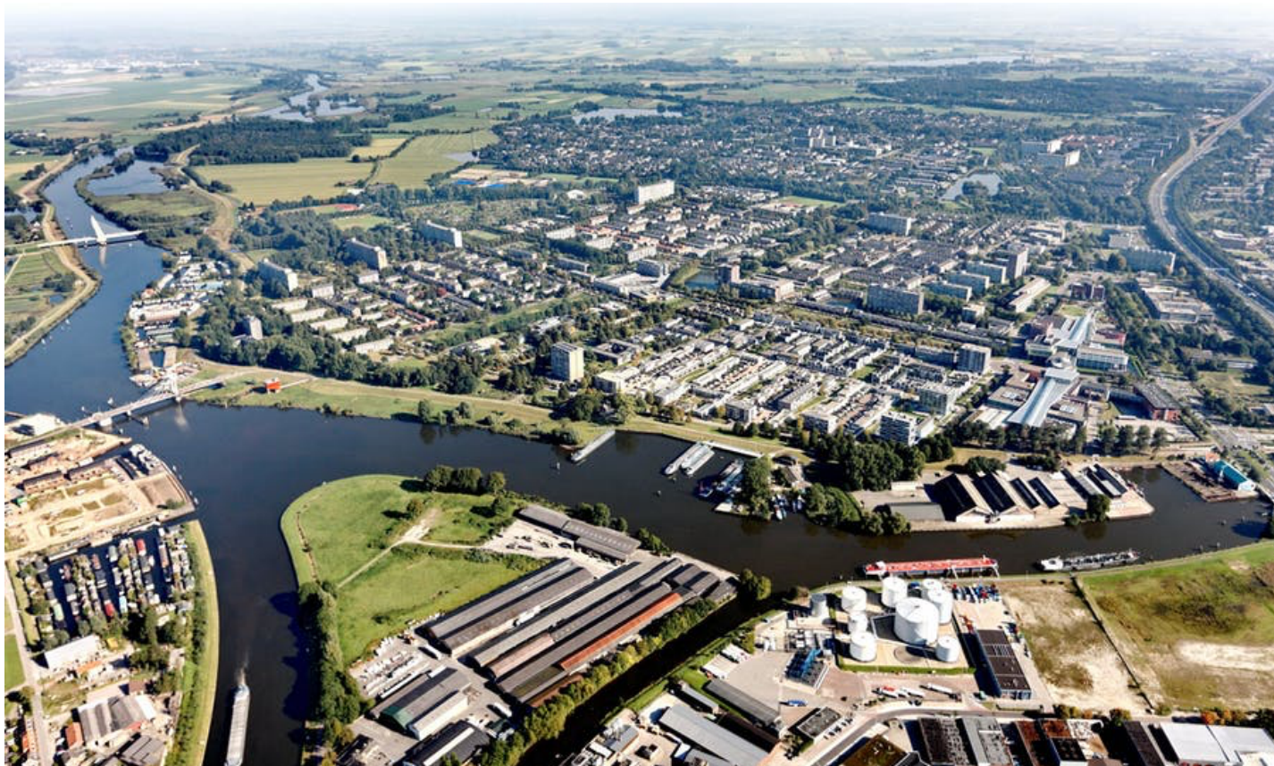
Luchtfoto van het gebied van de Stadsdijken in Zwolle. Aannemers Dura Vermeer en Ploegam ontvangen bij dit project een vooraf vastgestelde marge van 14% voor winst, algemene kosten en risico. Foto: Hoogwaterbeschermingsprogramma
