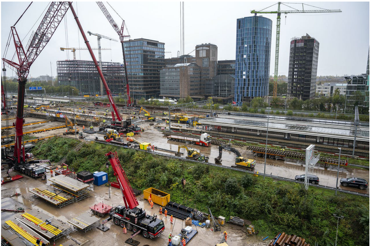
Werkzaamheden aan de A10 en het spoor bij station Amsterdam Zuid in november 2019. ANP
